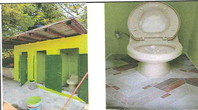
Foto 3: Sustitución de sanitarios.
