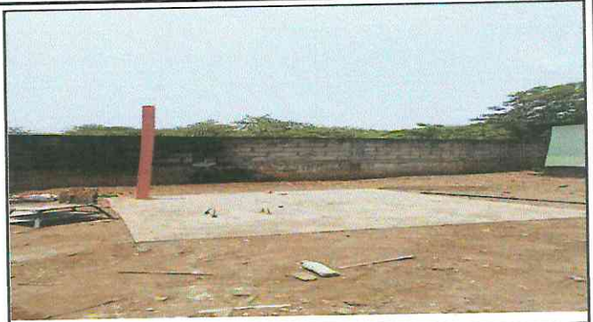
Foto 2: INSTALACIÓN DE POSO DE ABSORCIÓN
